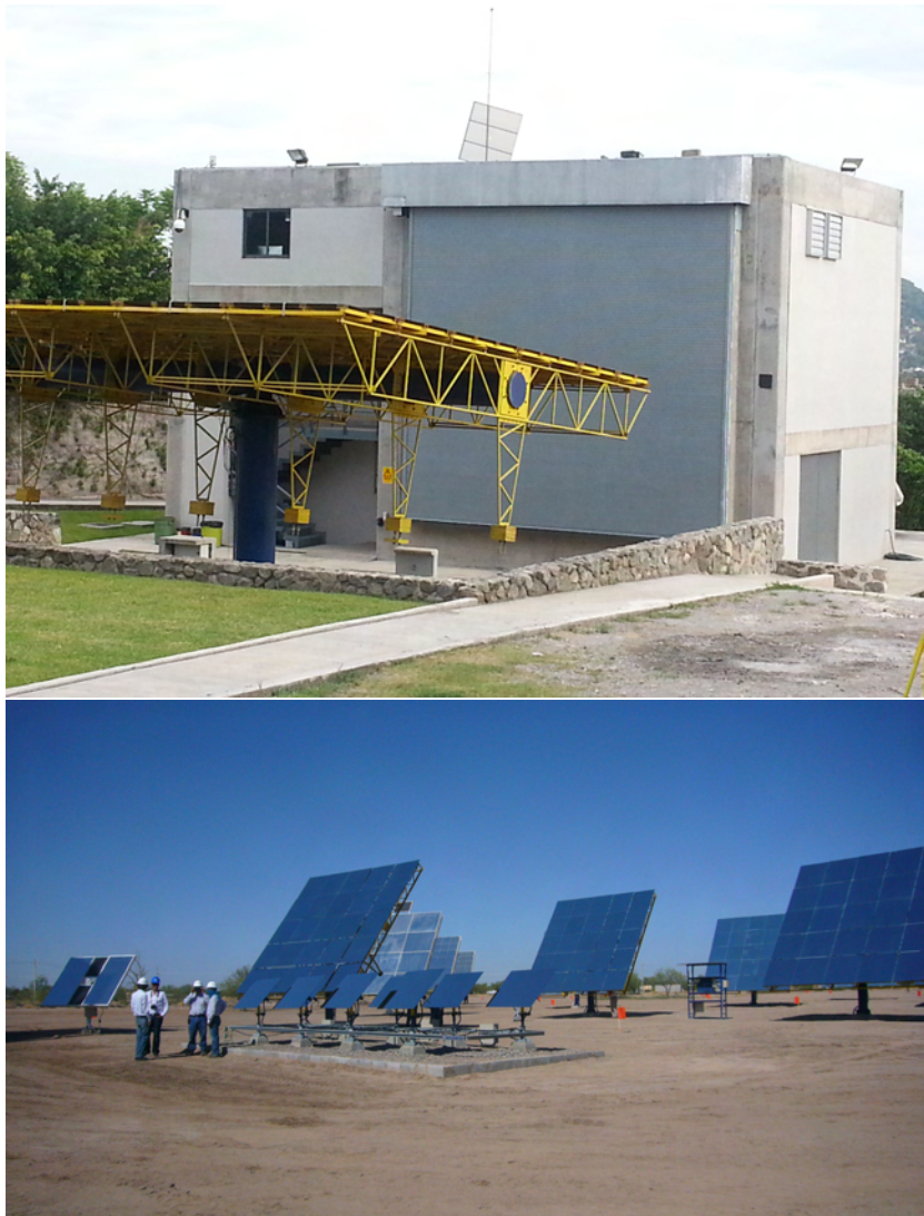
Figura 2: Horno Solar concentra 81m^2 en centímetros y campo de helióstatos
